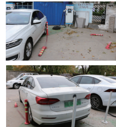
图：调研过程中发现某充电站防撞设施已出现损坏
