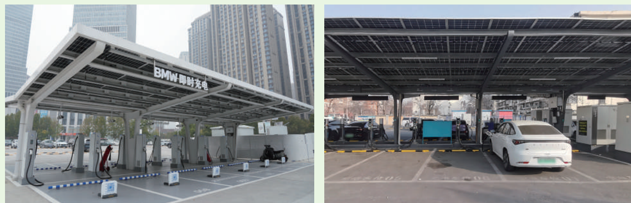
图：建设了光伏车棚的充电站
