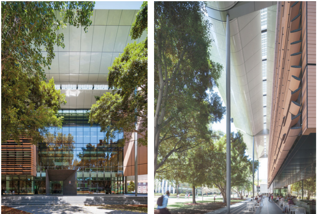
（图源：超低能耗教学实验楼建设与研究——以山东建筑大学教学实验综合楼为例） 图 3-3-1 新南威尔士大学泰瑞能源技术大楼（图源： https://fjmtstudio.com/projects/tyree-energy-technologies-building/ ）
