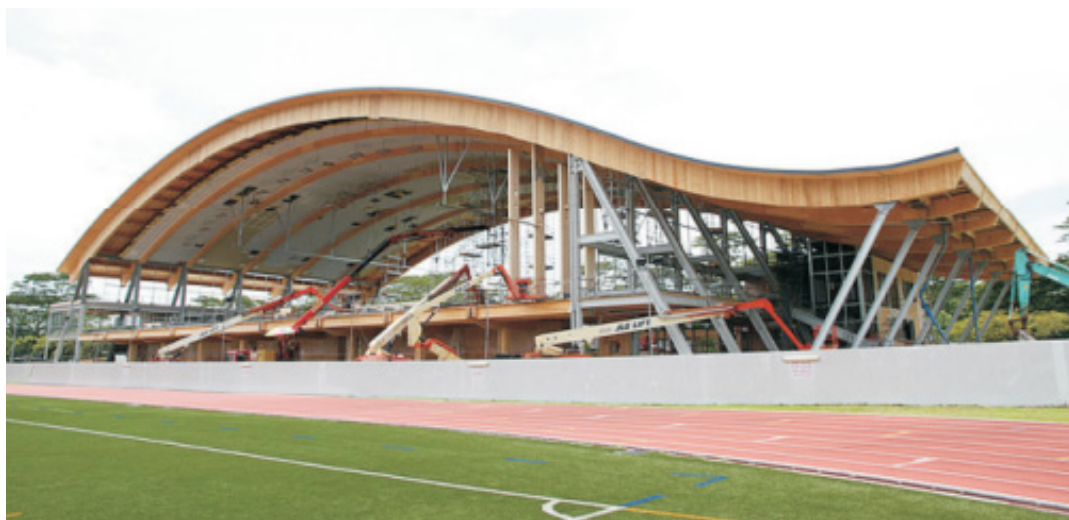
图 3-1-1 新体育馆木结构施工照片 (图源：新加坡高等教育机构绿色校园建设研究)
