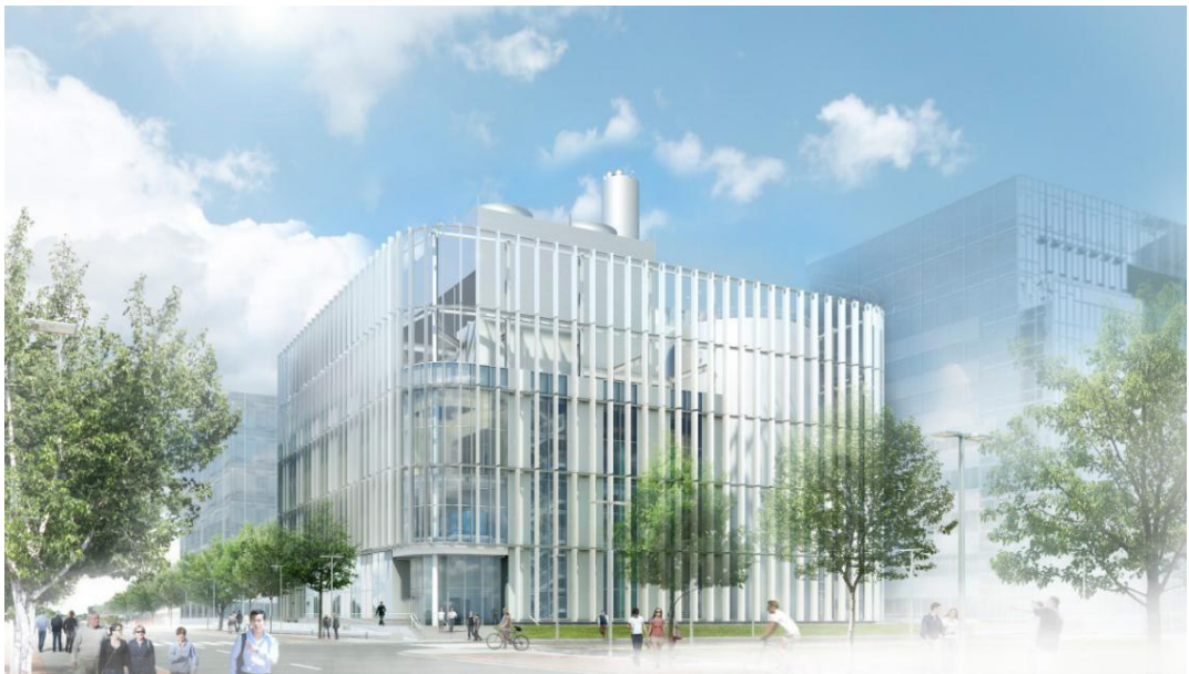
图 2-1-1 哈佛大学位于奥尔斯顿的新区能源设施 (DEF) (图源： https://green.harvard.edu/news/highly-efficient-energy-system-power-harvards-allston-campus )
