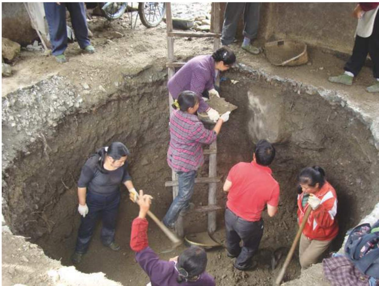
组图：沼气项目入驻村中，先选定地址后挖坑，再搭建模具，然后外层浇筑，最后抹上水泥填平。
