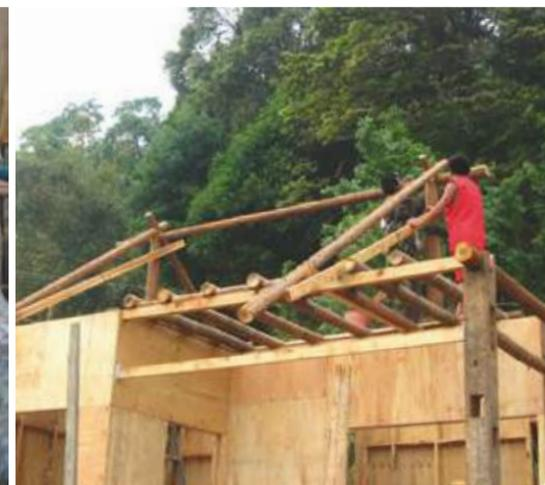
文峰介绍说，这种竹楼与当地钢混结构民居相比，造价降低 20%、自重减少 40%、可减少 80% 不可降解垃圾，建筑过程中减少碳排放量 10 吨左右，抗震设防达到 8 度，使用年限为 20 年。同时新型原竹楼面采用了新的技术，密排原竹替代钢筋混凝土现浇楼板了结构；在原竹结构层下面挂石膏板作为防火层；用原竹结构层上面铺竹纤维和水泥增强生土作为上部防火层；利用药剂真空加压解决了原竹防腐、防霉、防蛀。
