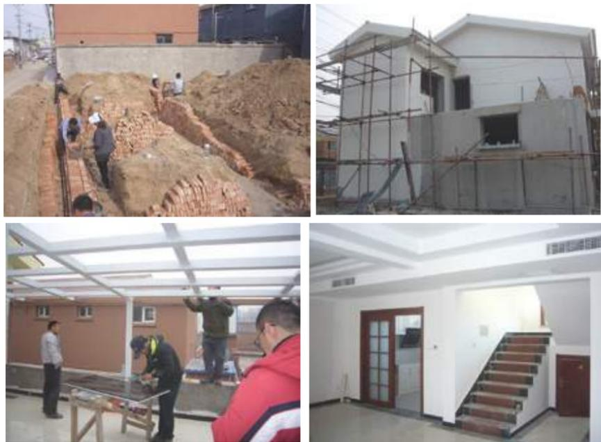
左页组图：低能耗建筑农宅在建设过程中要经过打地基、建框架、浇筑水泥等工程步骤，除此之外还要铺设薄膜光伏板、地暖，安装水源热泵等，屋面还使用了11cm的挤塑板。
