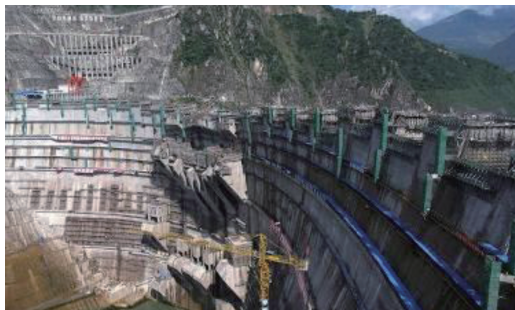
图为云南小湾水电站的 300 米级混凝土双曲拱坝
