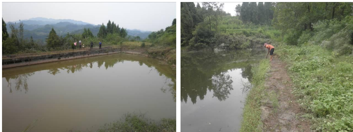
村民正在对山坪塘进行维修改善
