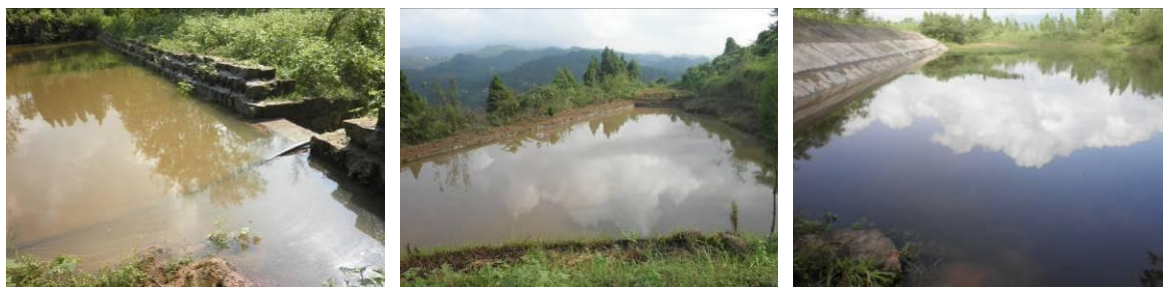
三个维修改善完成后蓄水的山坪塘
