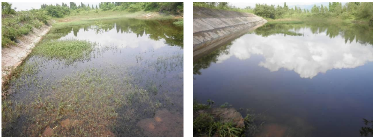
第一个山坪塘维修改善前后照片
